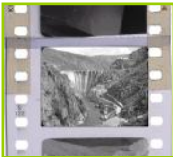
1956 Empalme reforzado con soporte de nitrato
