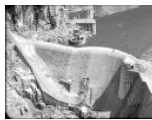
Ataguía o presa auxiliar
