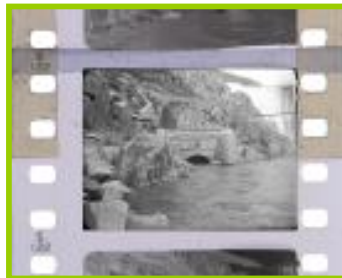
1956 Empalme reforzado con soporte de nitrato
