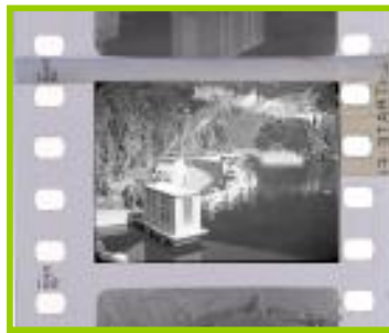
1956 Rotura reparada con soporte de nitrato
